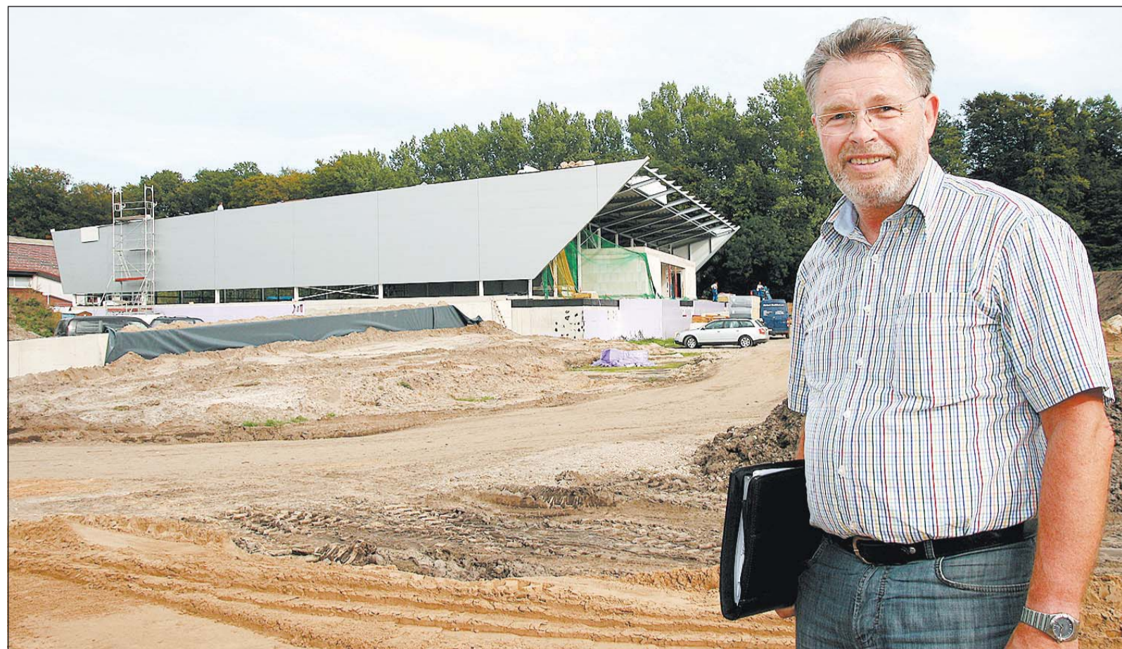
Jens Wurr, Projektleiter des für die Belüftungstechnik zuständigen Unternehmens, ist mit seinem Team derzeit auf der Baustelle
